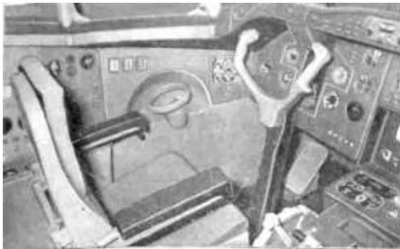
Рис. Б. 2. 53. Відпрацювання на макетах у натуральну величину кабіни літака: а – лівий борт, б – правий борт, змінена форма штурвала. КБ Антонова, 1970-ті рр.
