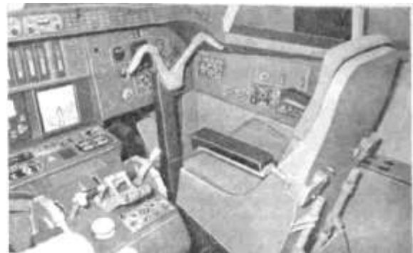
Рис. Б. 2. 53. Відпрацювання на макетах у натуральну величину кабіни літака: а – лівий борт, б – правий борт, змінена форма штурвала. КБ Антонова, 1970-ті рр.
