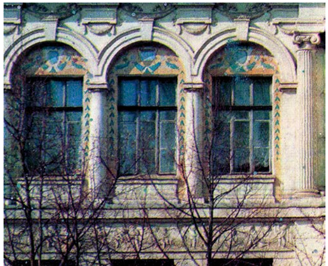
Іл. 19. Майолікове панно на фасаді будівлі Харківського художнього музею (колишній особняк) на вул. Жон Мироносиць, 11. Арх. О. Бекетов, 1912. Фото: Л. Соколюк
