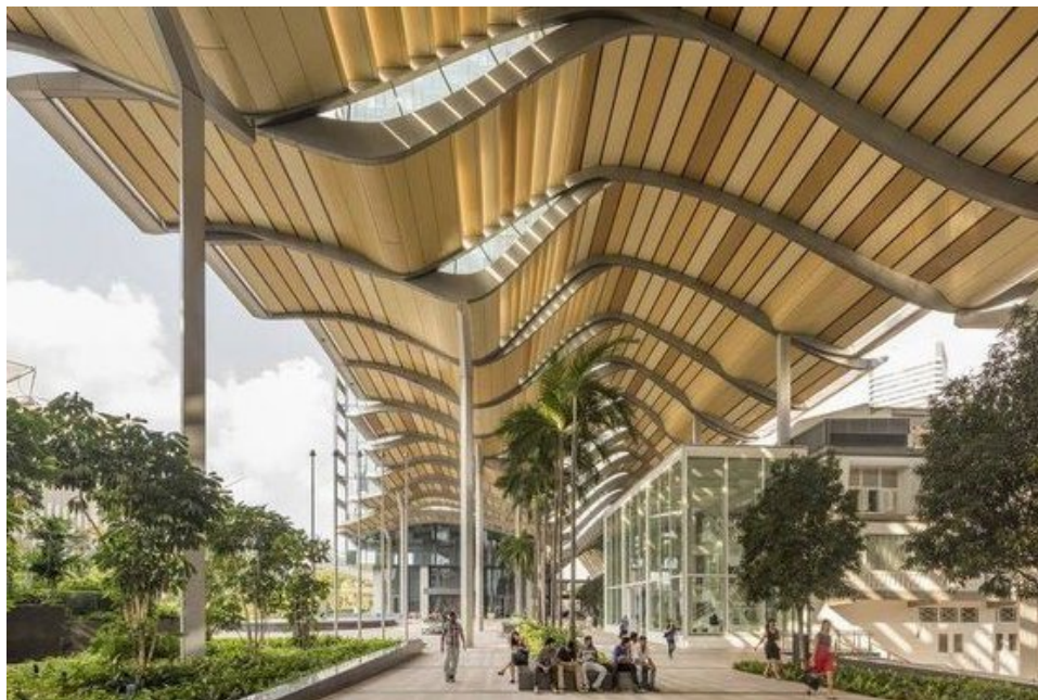
Рис.17 Центр Сінгапуру, South Beach Tower і Marriott Hotel
