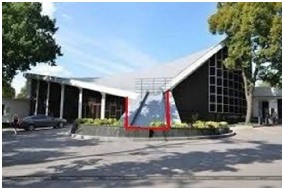
Рис. 8. Приклад колон при будівлі зі схожою формою даху
