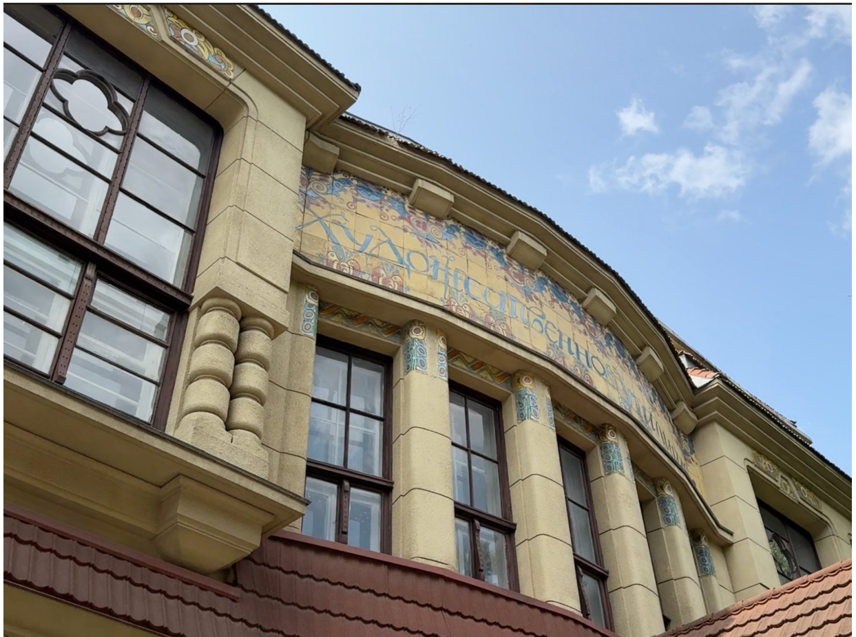
11.Іл 5.2. Кадр майоліки на фасаді першого корпусу ХДАДМ.
