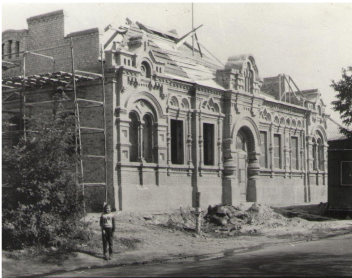
Іл. 4.2.2 Будівля музею під час робіт з реконструкції. Кінець 1980-х.
