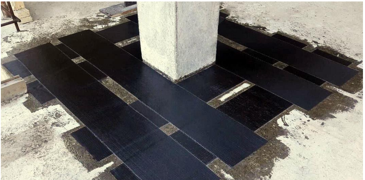
Рисунок 3 — Посилення плити перекриття вуглецевою стрічкою
