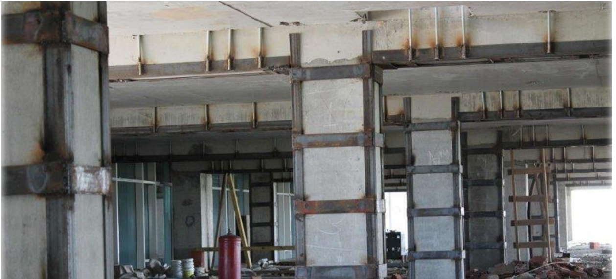
Рисунок 6 — Армування несучих конструкцій будівлі металом
