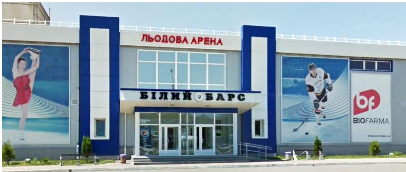
Рисунок 3.1 – Спортивний комплекс “Льодова арена”, м. Дніпро Фасади виконані у сучасному стилі з вентильованим облицюванням:
