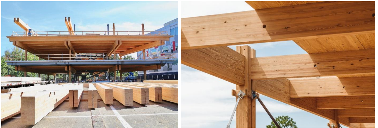
Рис. 17 – деревина Glulam: а – будівля штаб-квартири Adidas, Портленд, конструкції виготовлені за технологією Glulam; б – загальний вигляд деревини Glulam
