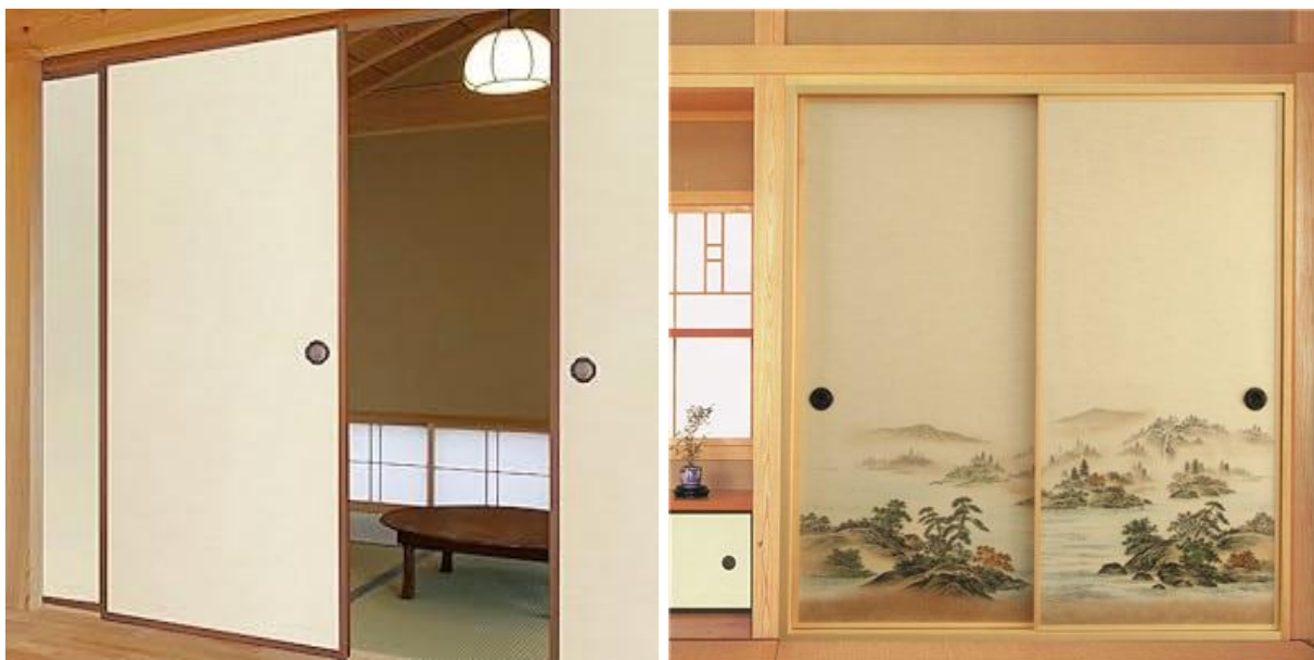
Рис. 7 – Розсувні перегородки фусума: а – стандартний вигляд перегородки; б – перегородка із розписом
