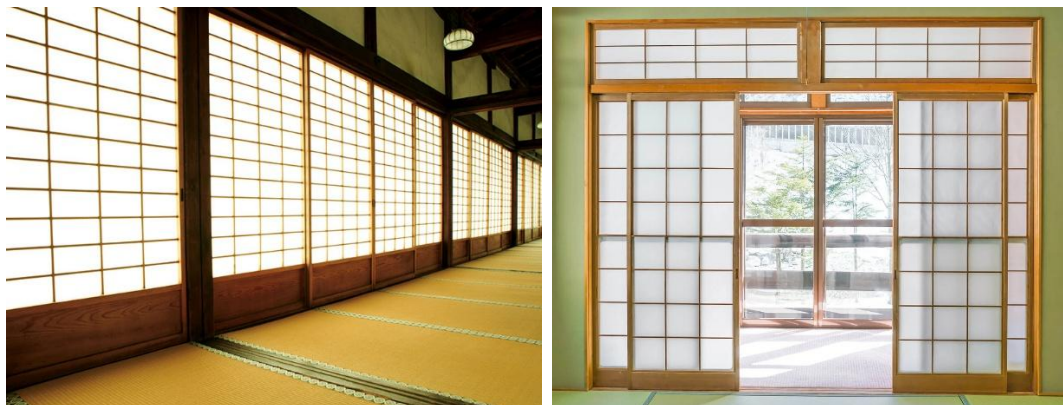
Рис. 8 – Розсувні перегородки шьоджі: а – приклад, як шьоджі м'яко розсіюють світло; б – стандартний вигляд перегородки
