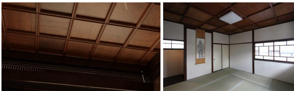
Рис. 9 – Кесонна стеля готенджьо: а – патерн виконання кесонної стелі; б – приклад виконання в традиційному інтер'єрі
