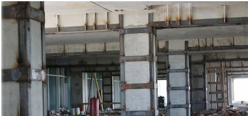
Малюнок 1 Підсилення будівельних конструкцій, Ізраїль Джерело:kskconstruction.com
