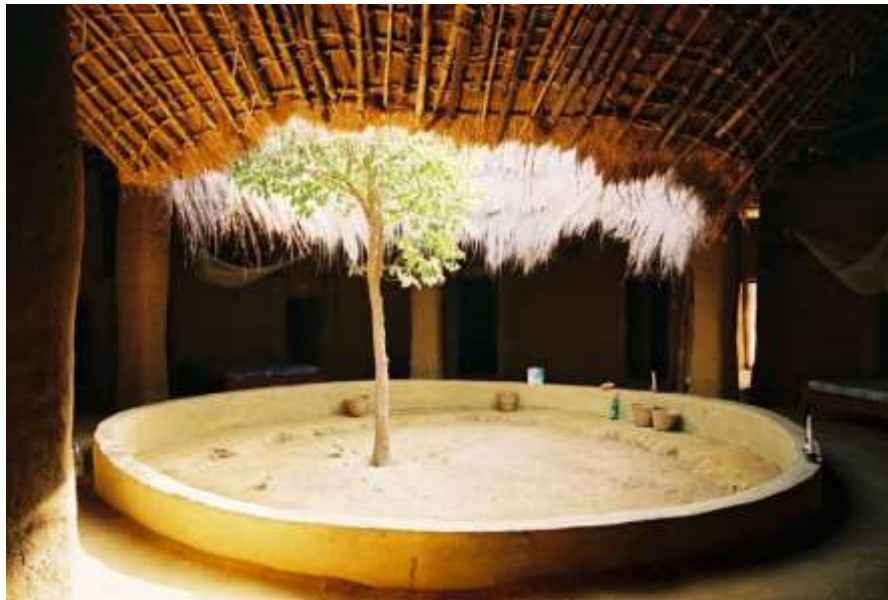
Рисунок 2. Дощова вода тече з даху на подвір'я, всередину будівлі, оточеної кімнатами. Фото: Alberto Foyo.
