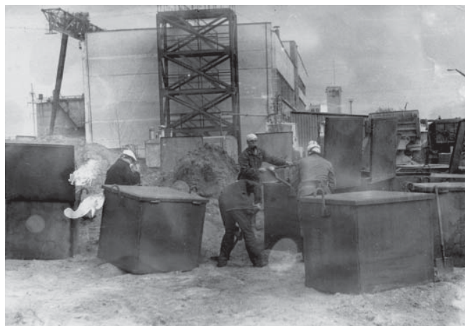
Рис. 2. Завантаження металевих контейнерів забрудненою землею для вивезення її зі станції
