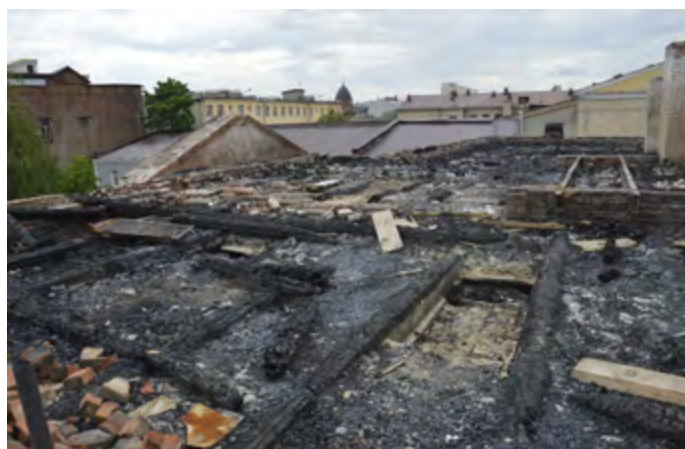
Ил. 8. Зруйнований дах колишньої будівлі М. Соколова. Фото з відкритих джерел, 2022 р.
