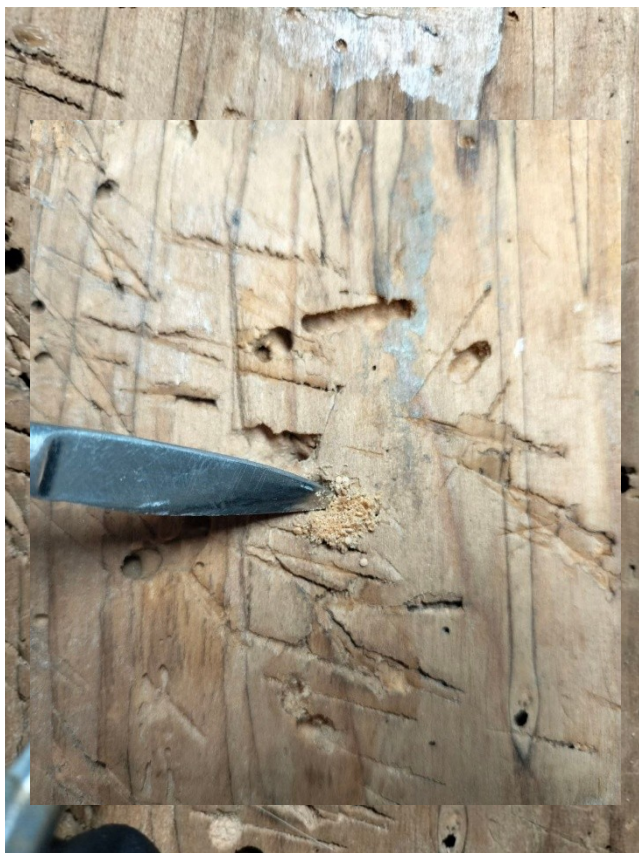
Іл.13. Процес видалення деструктованої деревини (фото Н. Антоненкової)
