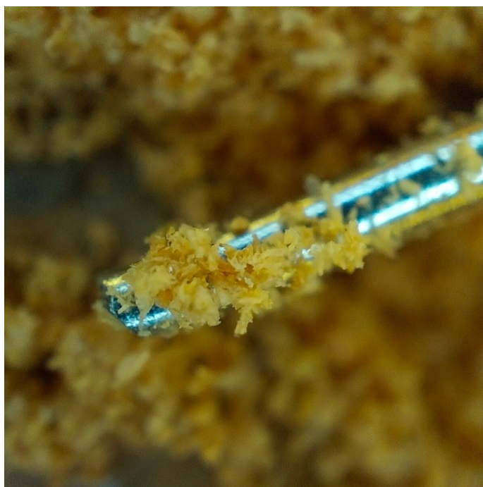
Іл.13. Процес видалення деструктованої деревини (фото Н. Антоненкової)
