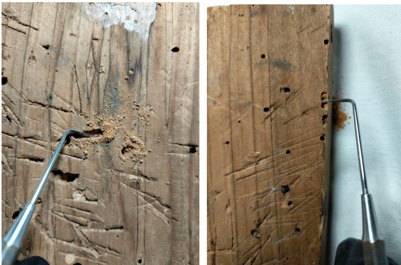
Іл.13. Процес видалення деформованої деревини (фото Н. Антоненкової)
