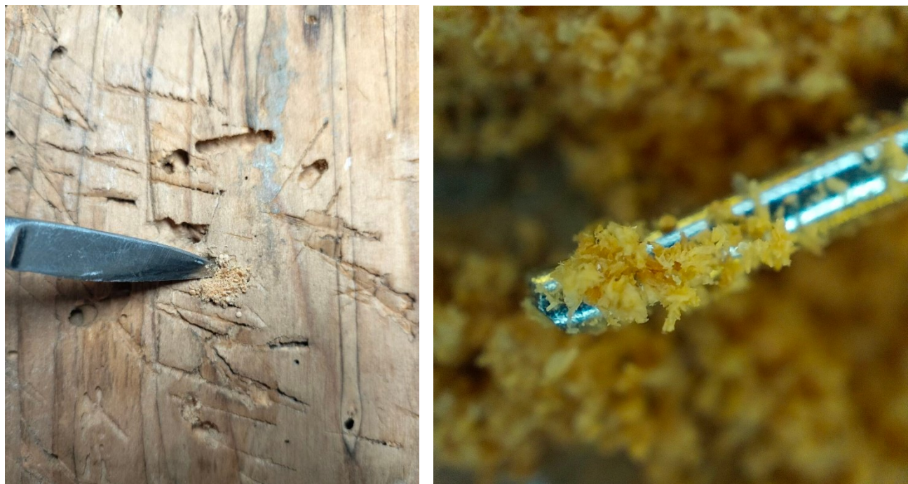
Іл.14. Процес видалення деформованої деревини (трухи) (фото Н. Антоненкової)
