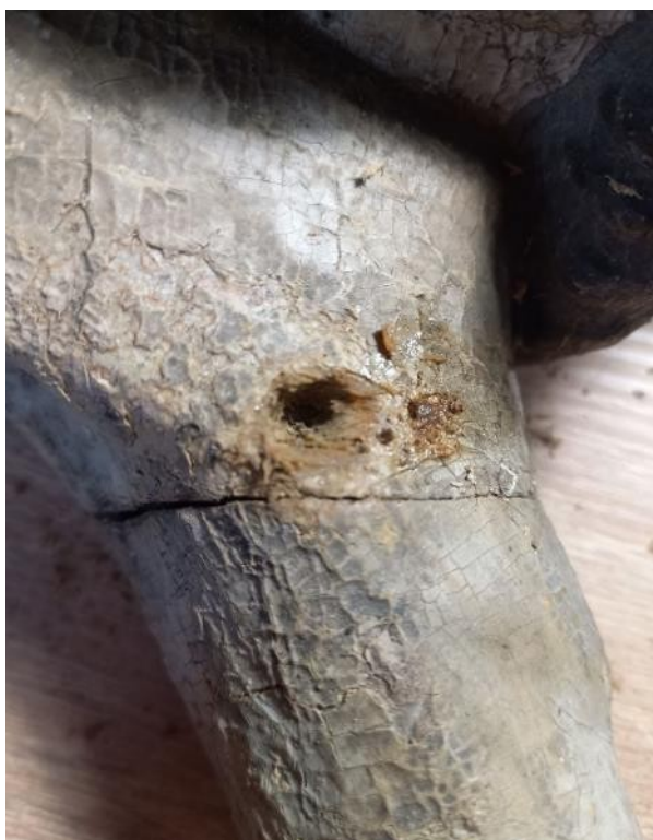
Іл.37. Цвяховий отвір після демонтажу
