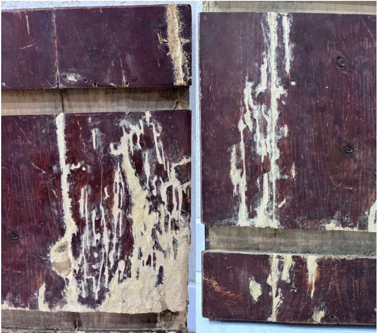
Іл. 62-63. Загальне фото тильної сторони в процесі поновлення основи: тестова проба №1
