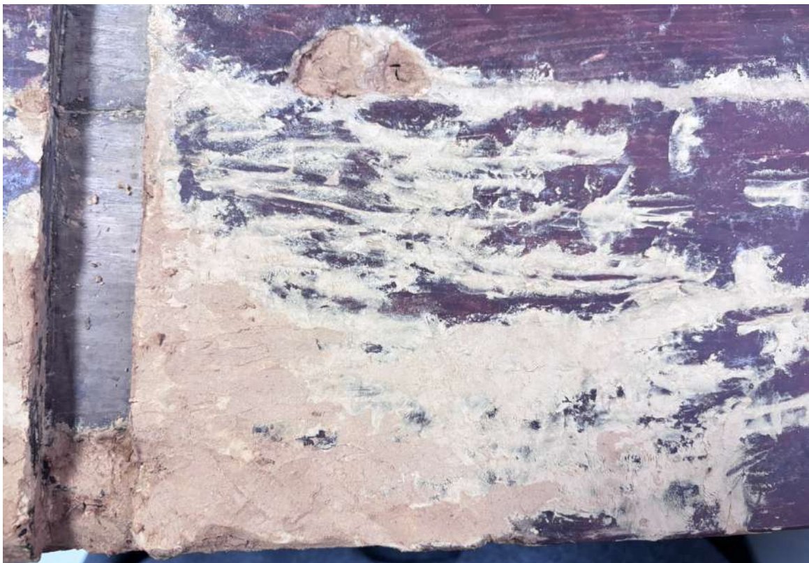
Іл. 66. Загальне фото тильної сторони в процесі поновлення основи: тестова проба №3
