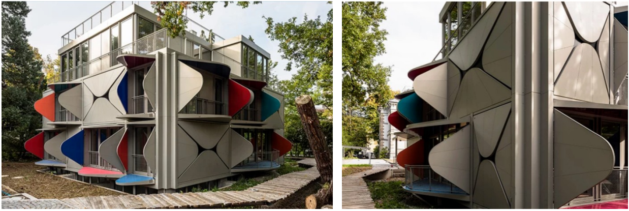
Рис.6. Будинок Ballet Mekanique : сонцезахистні пристрої. Арх. Мануель Герц (Manuel Herz);
