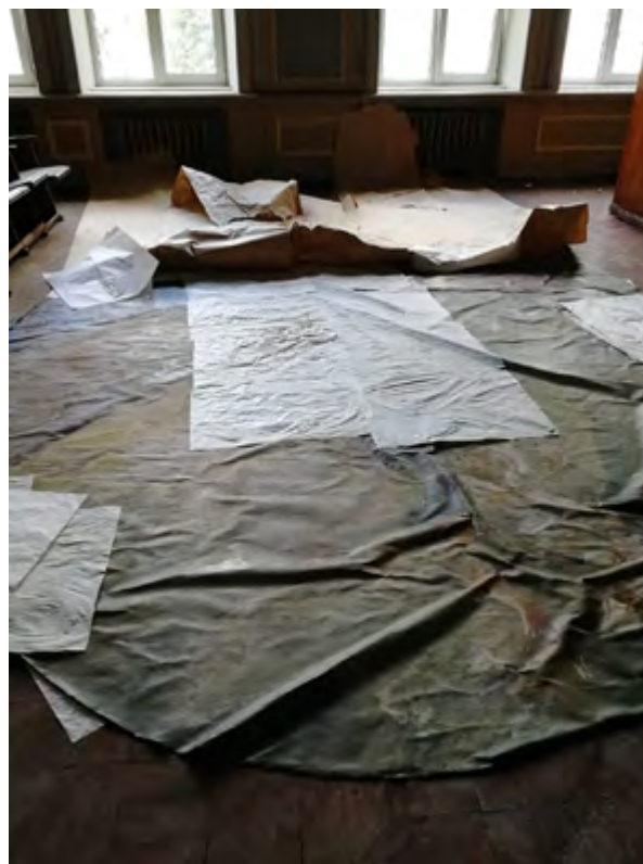
Ил. 9. Розпис М. Уварова після руйнування даху будівлі. Фото М. Кілогко, 2022 р.
