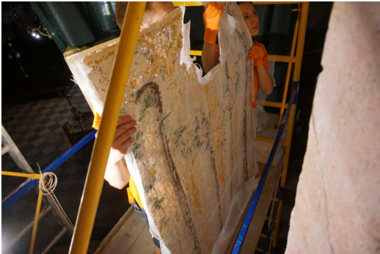
Фото. 6. Процес монтажу відшарованого живопису на нову основу
