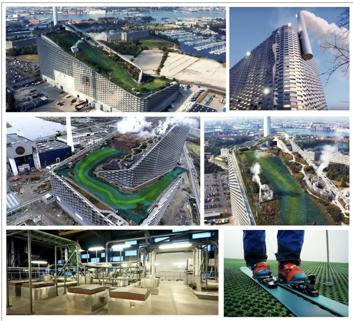
Іл.3. CopenHill — сміттєпереробний завод; м. Копенгаген, Данія. https://www.village.com.ua/village/city/city-news/336883-divitsya-yak-u-daniyi-pratsyue-smittepererobniy-zavod-z-lizhnoyu-girkoyu-na-dahu-copenhill
