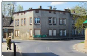
Житловий будинок на вул. Щецінека No2, в який об'єднано двосекторний бойовий бункер з двома входами.**
