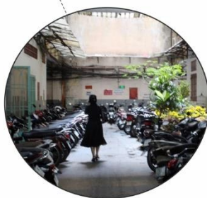
внутрішній двір житлового будинку 47-57 на вулиці Нгуєн Тай Бінь
