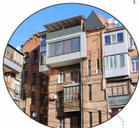
захоплення простору прибудовою утеплених балконів
