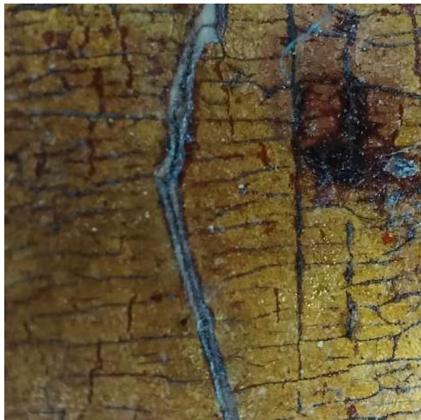
222. Тріщини, шпарини та кракелюри у левкасі.
